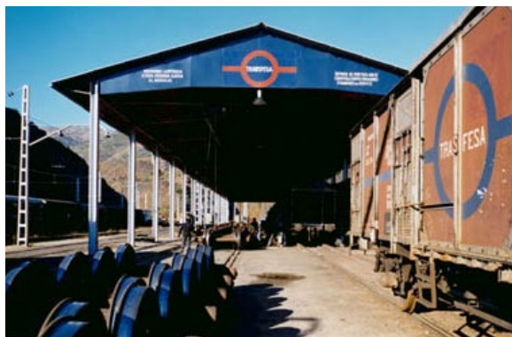
1950: Se construye la primera instalación de cambio de ejes en Hendaya .
